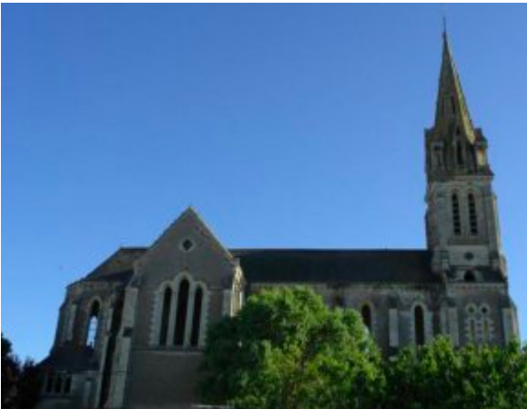
10. Eglise de Saint-Georges-des-Gardes Etat avant sa destruction en août 2006 Saint-Georges-des-Gardes, Maine et Loire Photo : Alain Guinberteau
