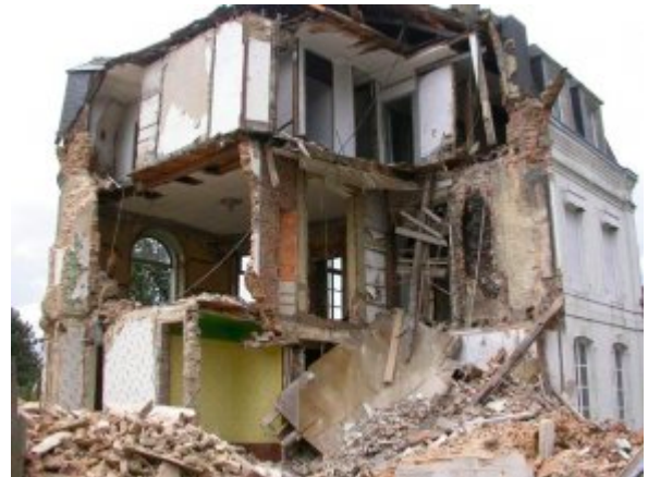
8. Château de la Trésorerie En cours de destruction, août 2006 Hardinguen, Nord Photo : D.R.
