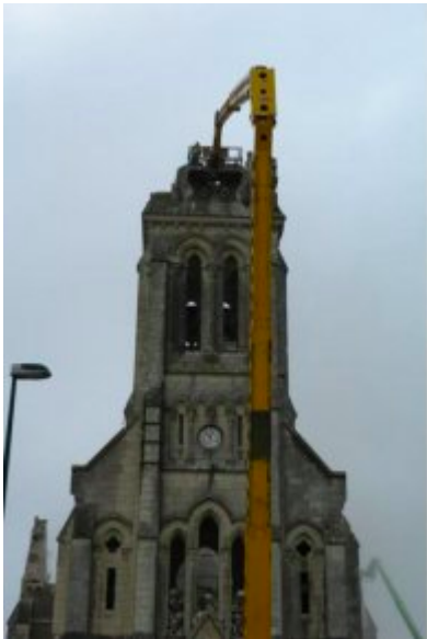
12. Eglise de Saint-Georges-des-Gardes En cours de destruction, août 2006 Saint-Georges-des-Gardes, Maine et Loire Photo : Alain Guinberteau
