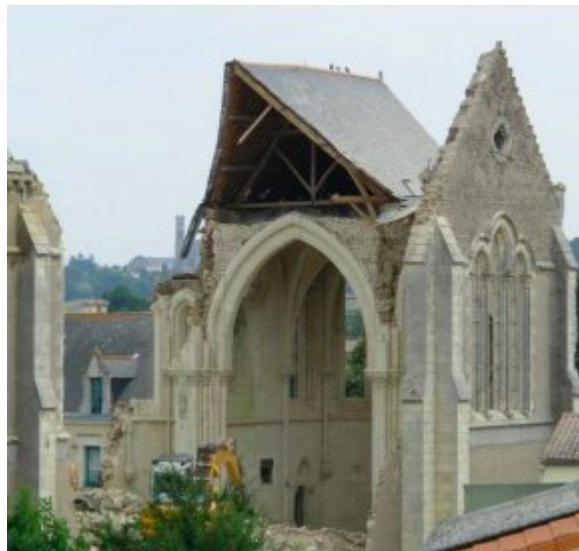
14. Eglise de Saint-Georges-des-Gardes En cours de destruction, août 2006 Saint-Georges-des-Gardes, Maine et Loire Photo : Alain Guinberteau
