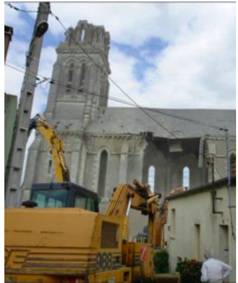
13. Eglise de Saint-Georges-des-Gardes En cours de destruction, août 2006 Saint-Georges-des-Gardes, Maine et Loire Photo : Alain Guinberteau
