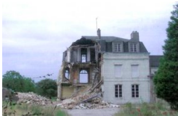
7. Château de la Trésorerie En cours de destruction, août 2006 Hardinguen, Nord Photo : D.R.
