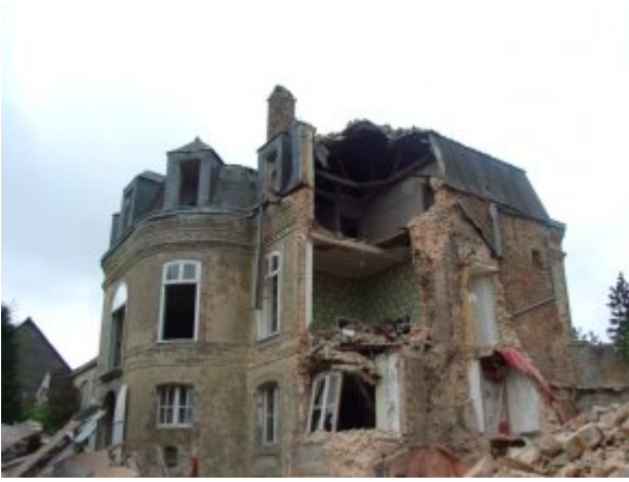
9. Château de la Trésorerie En cours de destruction, août 2006 Hardinguen, Nord Photo : D. R.
