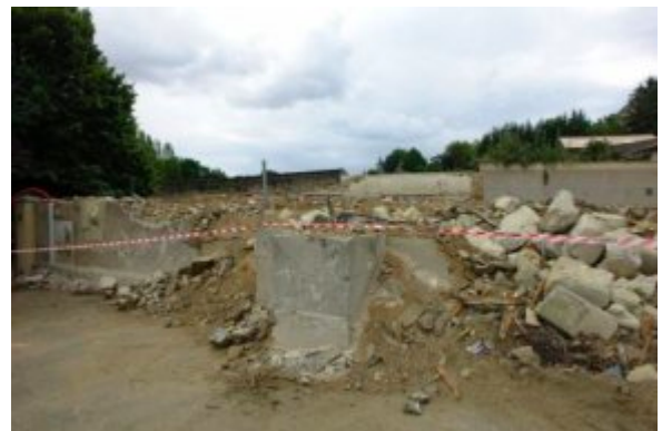
15. Emplacement de l'église détruite en août 2006 Saint-Georges-des-Gardes, Maine et Loire Photo : Alain Guinberteau
